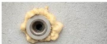
PENOSIL Espuma Multiuso PU-46m se utiliza especialmente para relleno de agujeros y huecos, la instalación de marcos de ventanas y puertas, y el sellado de juntas.
